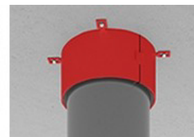
4. atornillar el collarín a la obra
